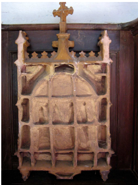
Structure des panneaux en terre cuite
